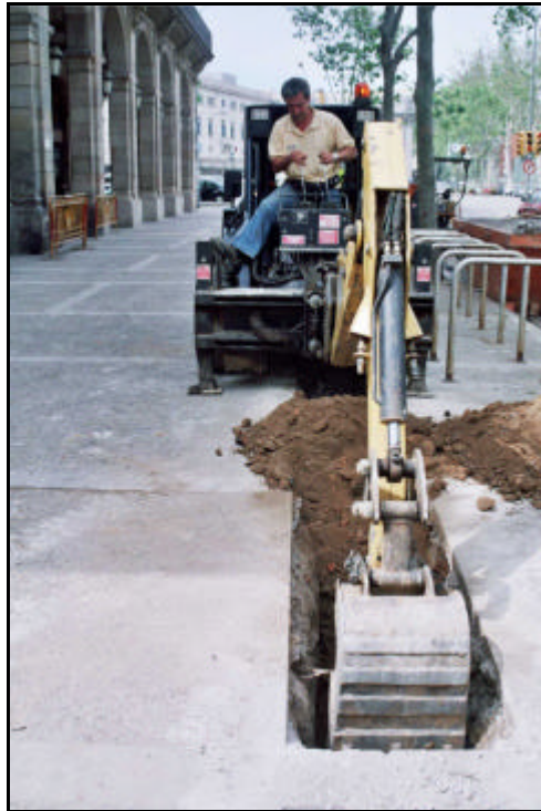
Foto 6. Vista general de la retroexcavadora realitzant els treballs d'excavació de la Rasa 3. Foto feta des del sud.
