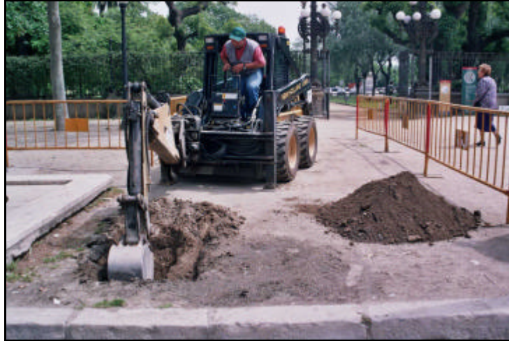
Foto 7. Vista dels treballs realitzats amb una bob-cat al Passeig Picasso, davant del Parc de la Ciutadella.
