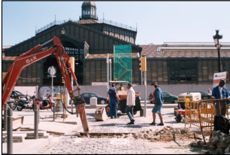
Foto 1. Vista general dels treballs excavació de la Rasa 1. Foto feta des del sud-oest.
