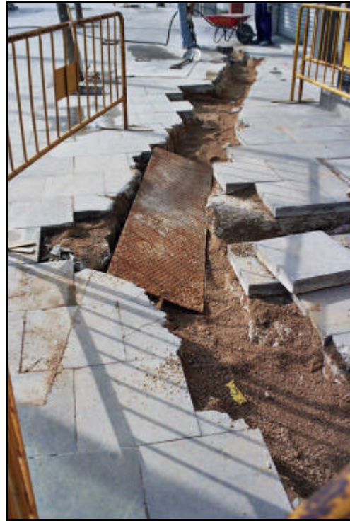
Foto 16. Vista dels treballs de la Rasa 5. Foto feta des del nord-oest.
