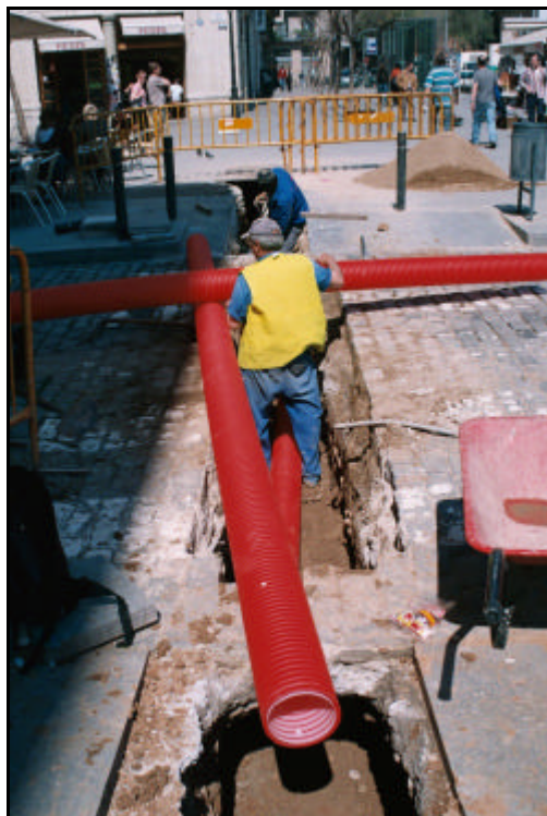
Foto 2. Vista dels treballs realitzats a la Rasa 1. Foto feta des del sud.
