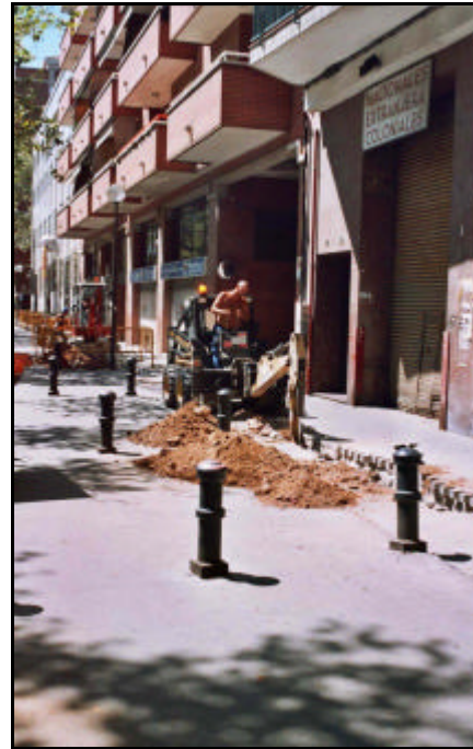
Foto 21. Vista dels treballs realitzats a la Rasa 6.
