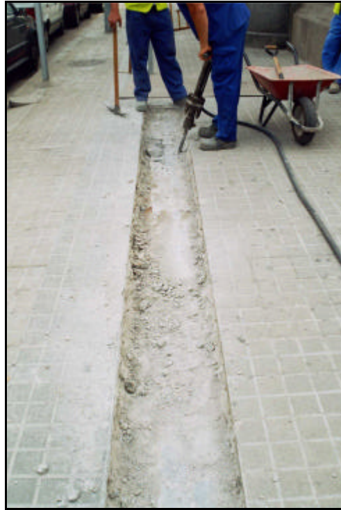
Foto 22. Vista dels treballs per aixecar paviment de la Rasa 7.
