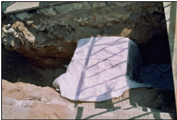
Foto 14. Vista del mur i dels paviments protegits amb geotèxtil.
