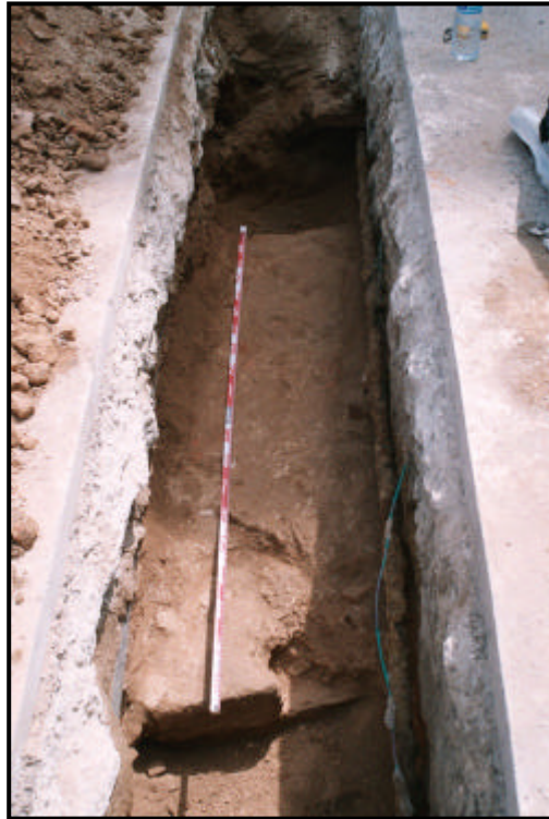
Foto 3. Vista general del mur 203 trobat a la Rasa 2 el C/ de la Ribera.
